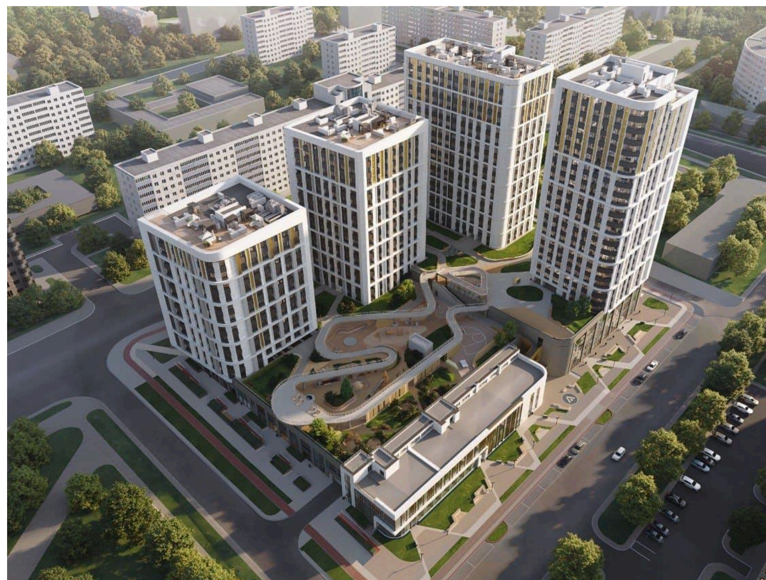
ООО СЗ «Строитэк» строительство ЖК «Аурум» г. Уфа ул. Комсомольская
