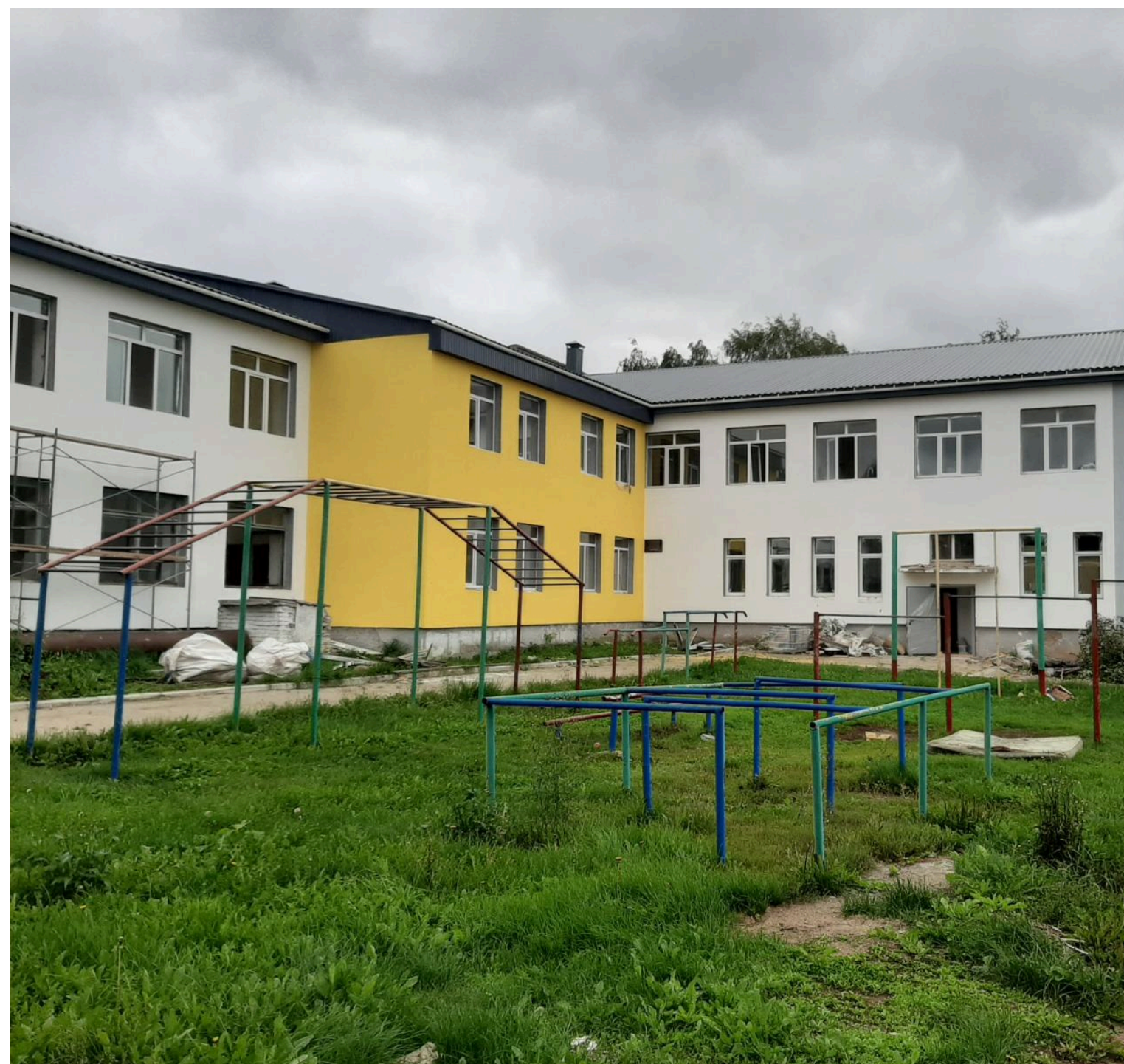
ООО УК «Альянс» Капитальный ремонт МОБУ ЛИЦЕЙ г. Бирск, РБ
