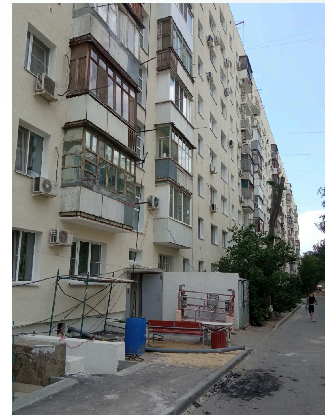
ООО «Имексо» капитальный ремонт фасадов МКД г. Волгоград
